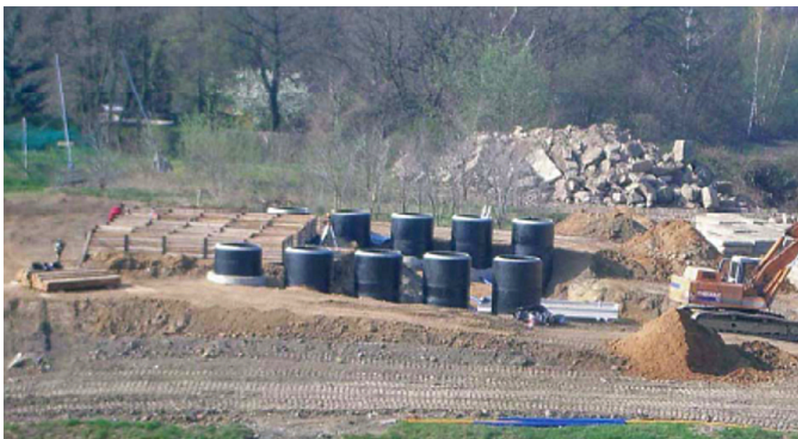
Abbildung 3 Die Lysimeteranlage während des Baus
